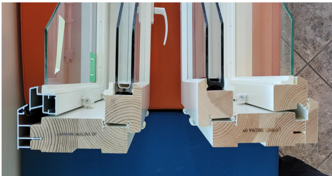
Kuva 5) Vaakaleikkaus puu-alumiini-ikkuna vasemmalla ja kokopuinen ikkuna oikealla.
